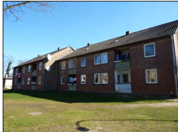
Abb. 30: Mehrfamilienhäuser in der Kapitän-Strasser-Straße
